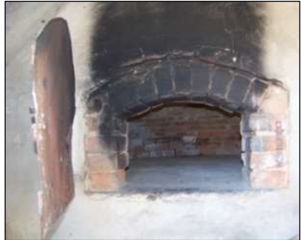
Historischer Steinbackofen, gemauert innen mit Backofensteinen, außen mit Ziegeln, seitlich verputzt
