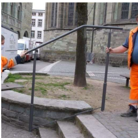
Installation der Handläufe zum Petrikirchhof
